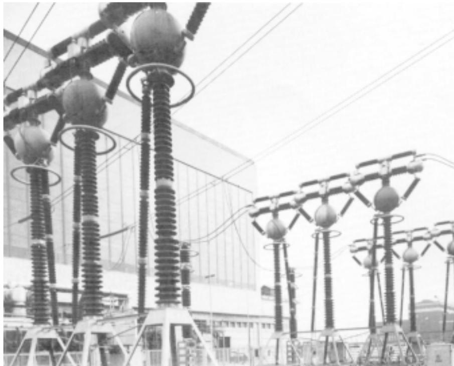
**Fig. 13 :** disjoncteur à air comprimé 420 kV.
