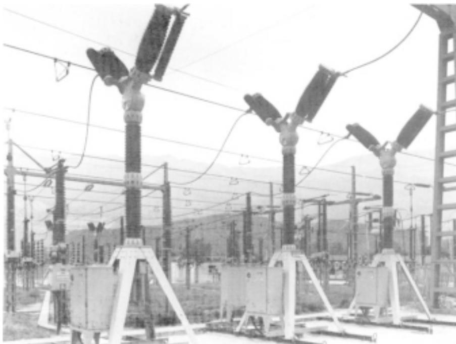
**Fig. 10** : disjoncteur 245 kV à SF<sub>6</sub>.
