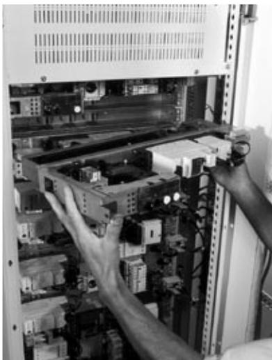
Fig. E32 : Tableau à unités fonctionnelles sectionnables-déconnectables
